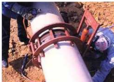
Hàn nối ống tại công trường ClouDamar
