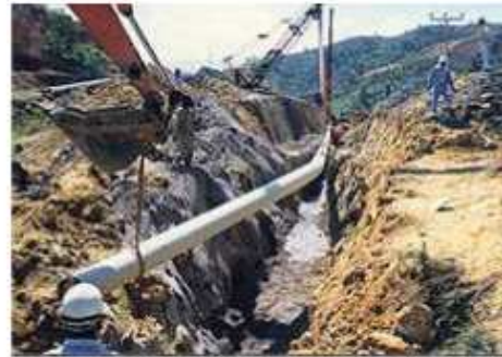
Quá trình đào rãnh
