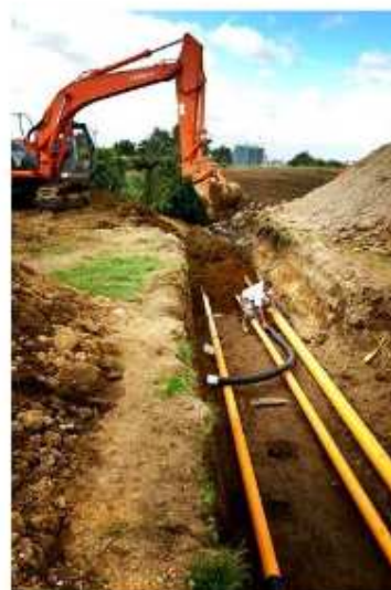
Quá trình lắp rãnh
