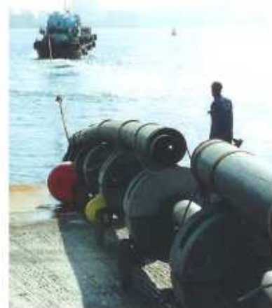
Thi công đường ống tại khu vực có nước
